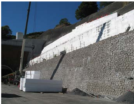
Оборудование рисберм верхней части выхода из тунеля
